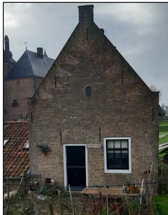
Achtergevel (rechter gedeelte)
