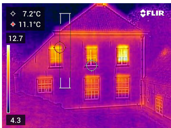
Linker zijgevel - warmteverliezen bij de gevelopeningen, schoorsteen en onder de goot van de Commandeurswoning zichtbaar
