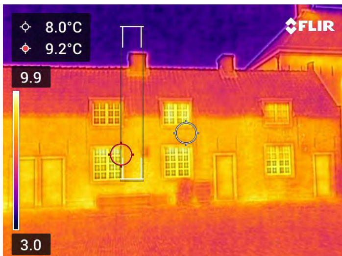
Voorgevel - warmteverliezen in de gevel, bij de gevelopeningen en schoorstenen van de barakken zichtbaar
