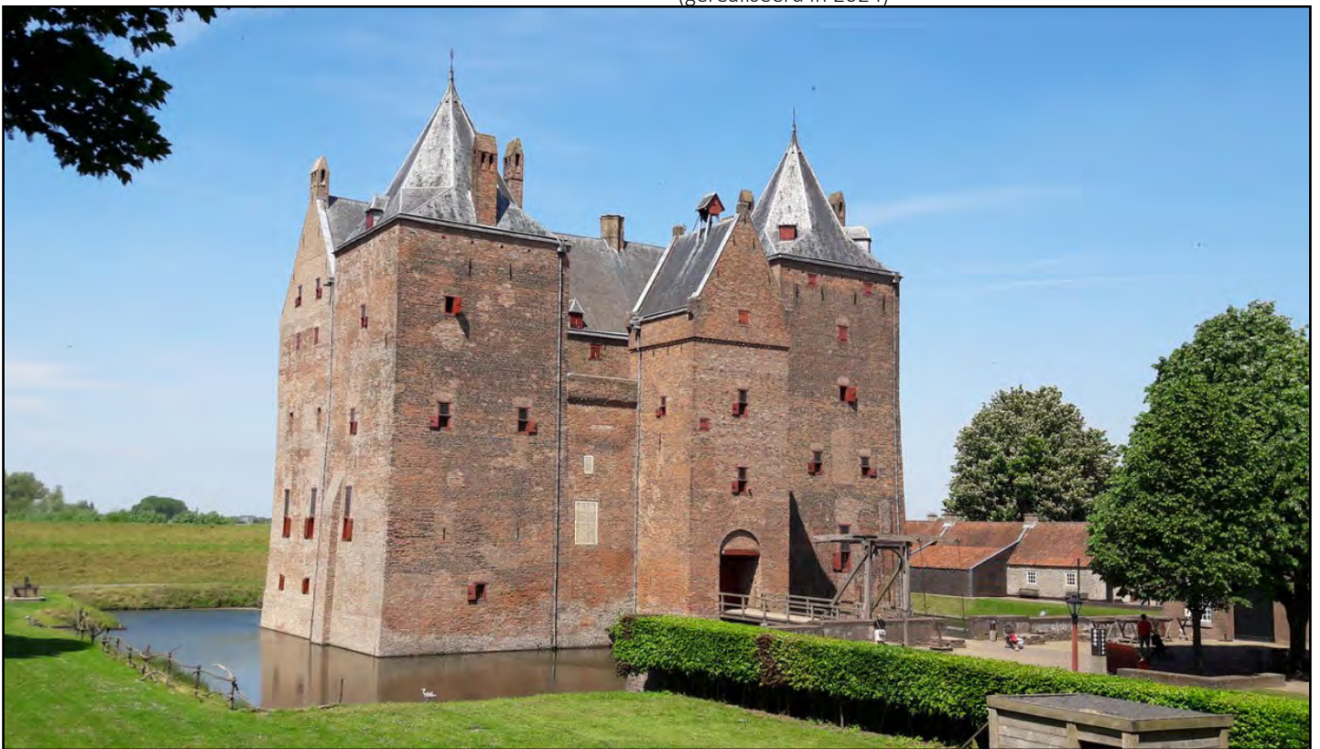
Zuid-oostgevel met toegangsbrug
