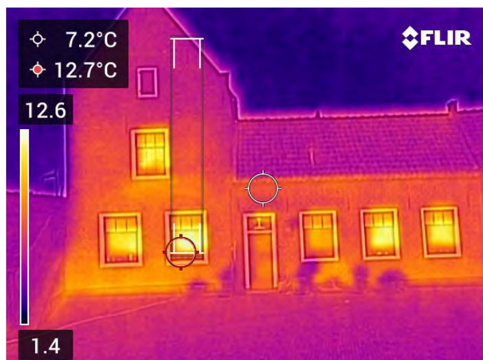
Voorgevel - warmteverliezen bij de gevelopeningen van de woning zichtbaar
