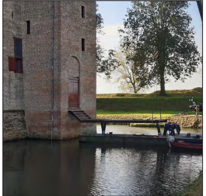
Westgevel met nieuwe miva toegankelijke brug (gerealiseerd in 2024)
