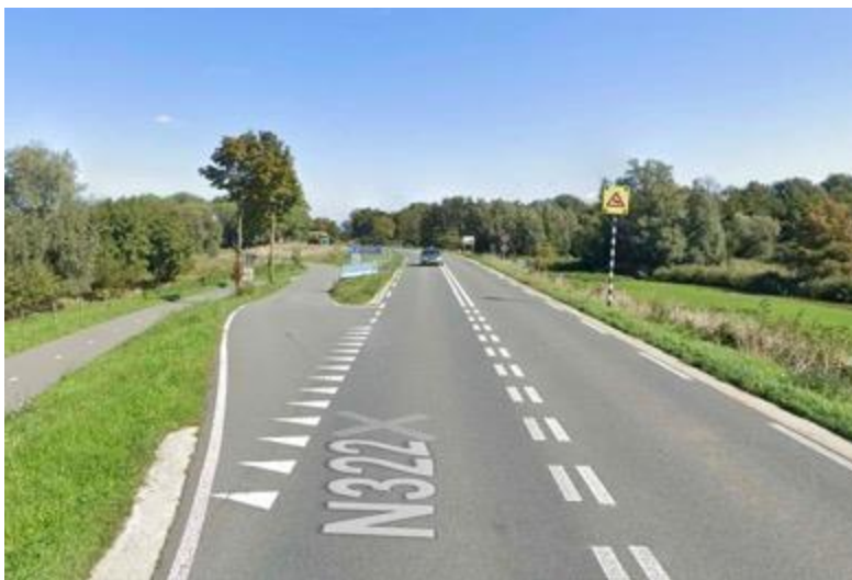
Figuur 7 Onduidelijk is dat hier de afslag is, er is ook geen uitvoegstrook
