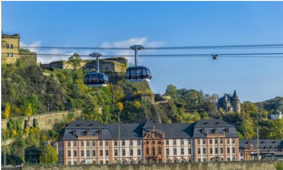
Figuur 18 Kabelbaan in Koblenz
