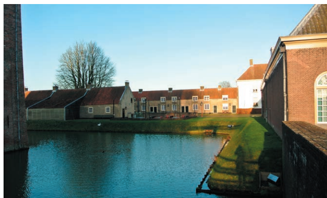
Huidige situatie met terras op locatie van voormalige Diaconie en Turfschuur.
