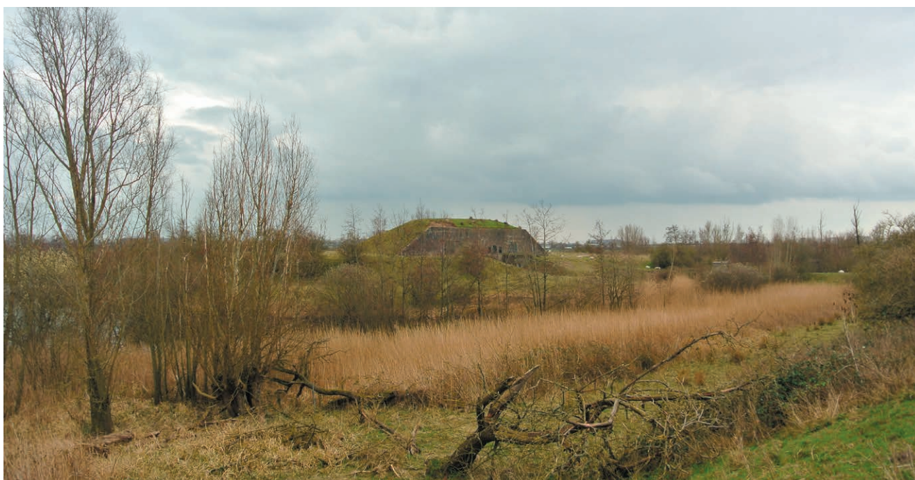
Huidig aanzicht Batterij onder Brakel
