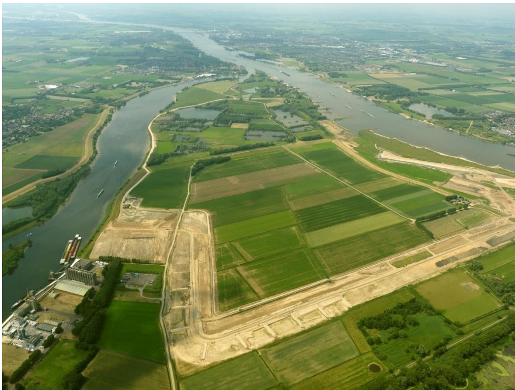
Aanleg van de Wakkere Dijk, 11-06-2014. Bron: Beeldbank Rijkswaterstaat, foto 497808.
