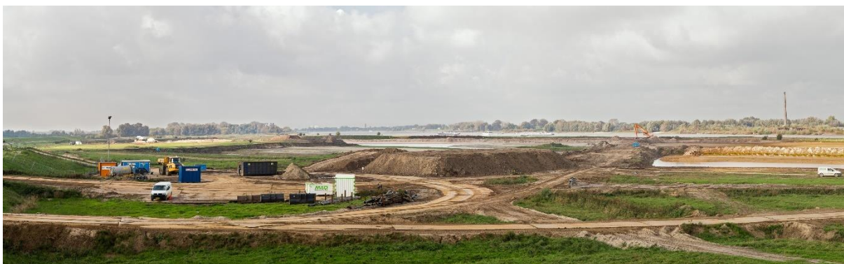
Uiterwaardvergraving en dijkverlegging Munnikenland, 06-05-2015. Bron: Beeldbank Rijkswaterstaat, foto 483310.
