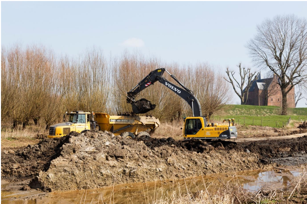
Uiterwaardvergraving en dijkverlegging Munnikenland, met op de achtergrond Loevestein, 06-05-2015. Bron: Beeldbank Rijkswaterstaat, foto 483311.
